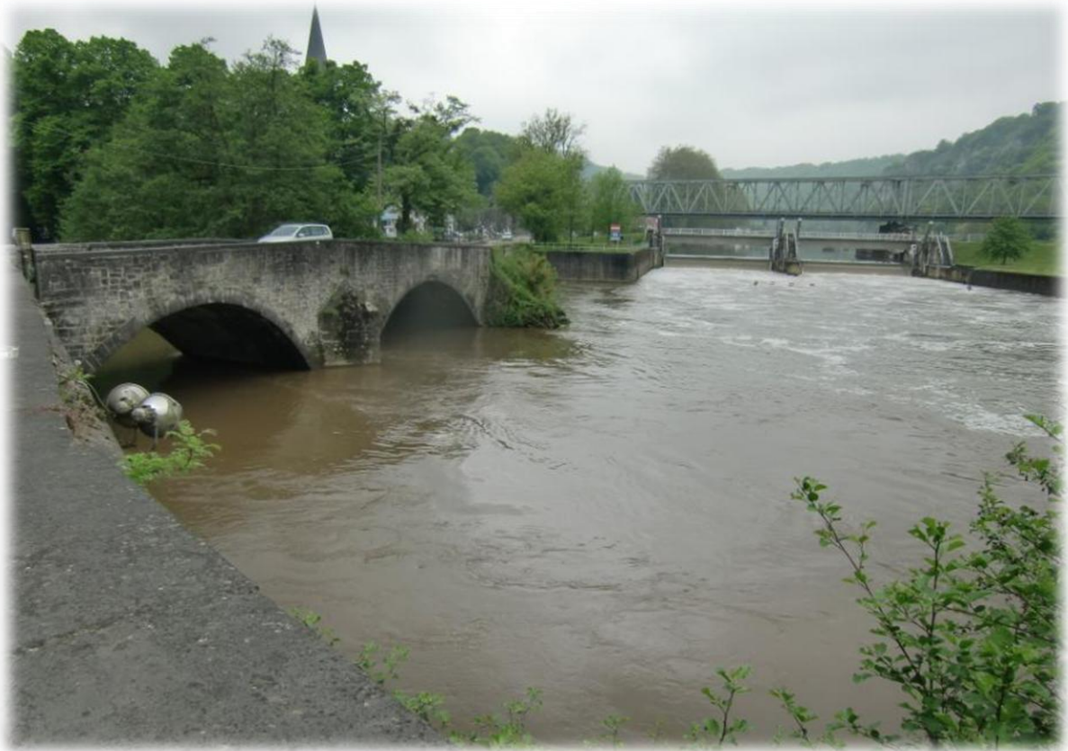
De Sint Jansbrug in Anseremme overspant de Lesse in de buurt waar de rivier samenvloeit met de Maas. De spoorwegbrug dateert van de periode 1896-1898 en is een van de eerste constructies van dit type die in België in staal werden gerealiseerd.
