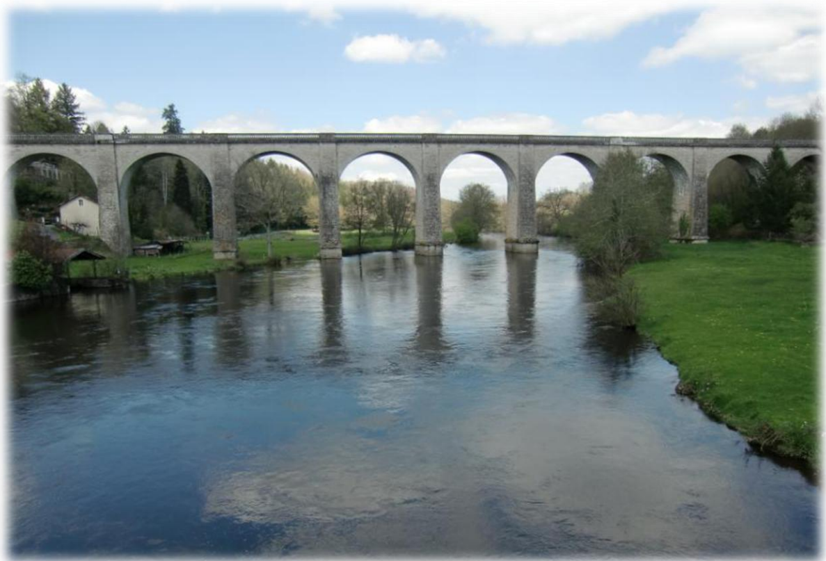
De viaduct die de Taurion overspant is 192 meter lang, 20 meter hoog en telt tien bogen.
