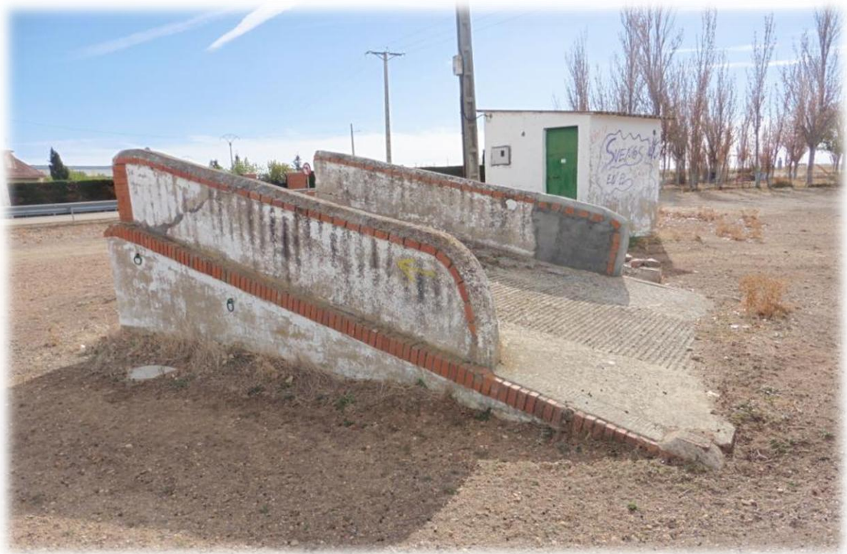
Aan de rand van het dorp staat een betonnen constructie om vee op een vrachtwagen te laten stappen.
