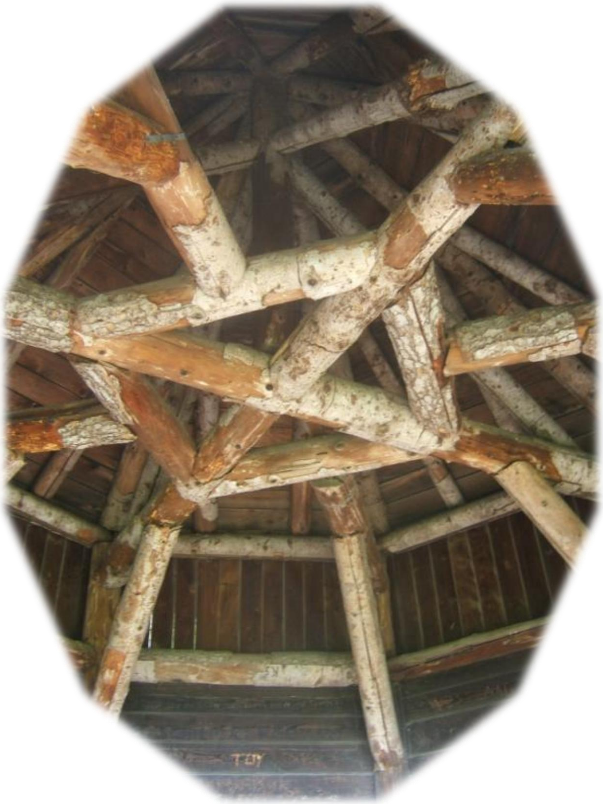
Dakconstructie van de kiosk
