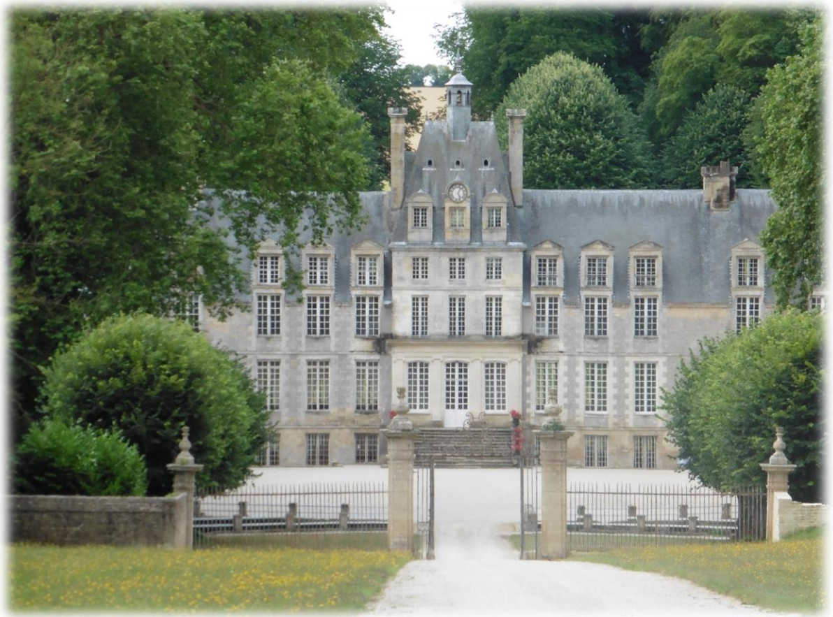
Het kasteel van Menneville is nog steeds bewoond.
